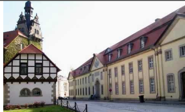
Rathaus II., ehemals herzogliche Reitbahn, gegenüber Rathaus I mit Turm und Kutscherhaus (links), Schlosstraße 11
